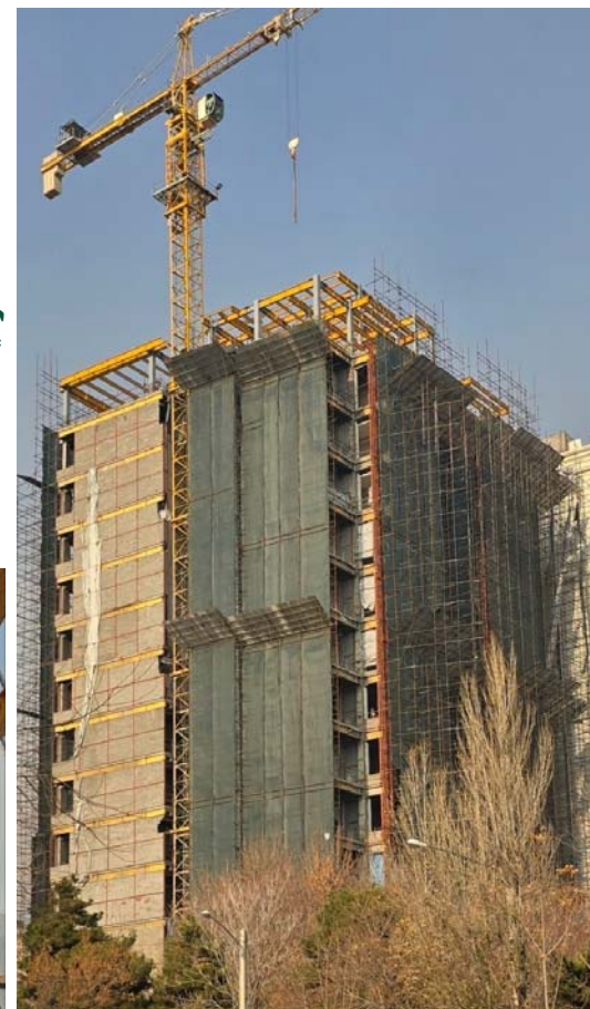
افزایش طبقه سه سازه برج باغ نسترن در زعفرانیه
