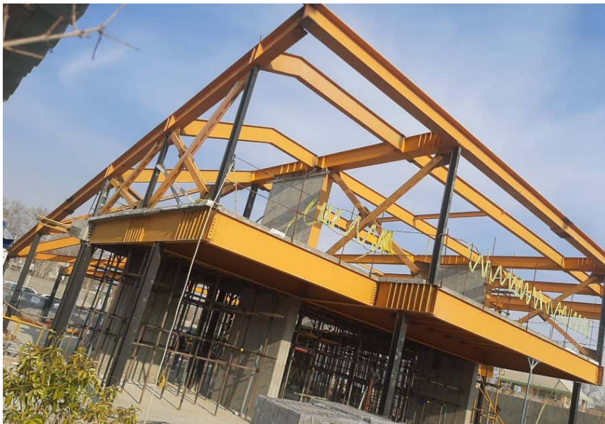
ویلای سی پروژه ژرفا محمدشهر (سازه فلزی در ترکیب با بتن)
