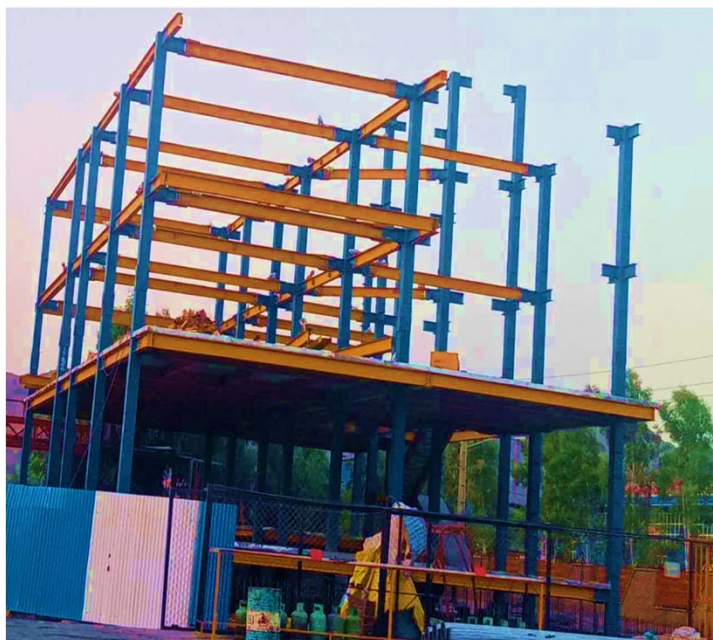
سازه فلزی کارخانه شرکت قیرآکام
