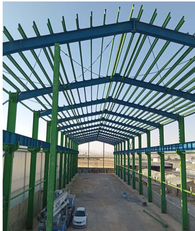
سازه های فلزی کارخانه شهرکرد - تابستان ۱۴۰۳
