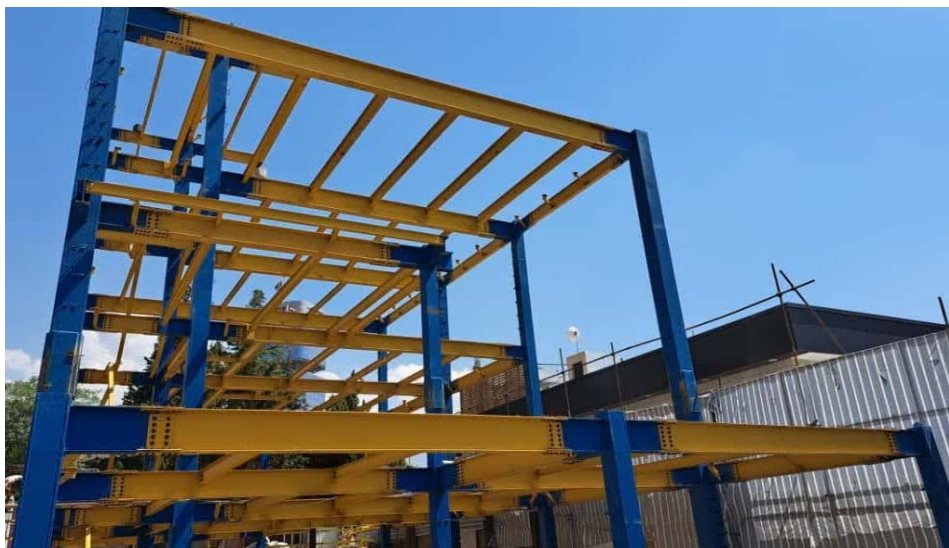
سازه فلزی پیچ و مهره های تیپ ویلایی در شهرک غرب - تابستان ۱۴۰۳
