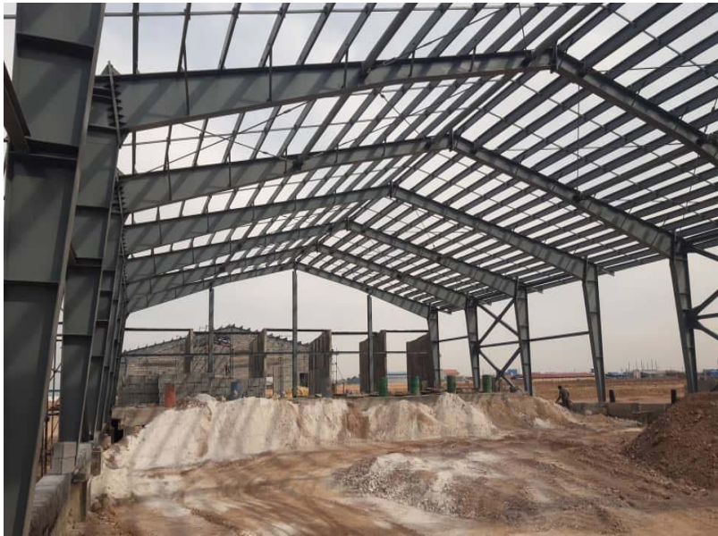
سازه های فلزی پروژه آب اکسیژنه شهرک صنعتی لیای قزوین - شهریور ۱۴۰۱
