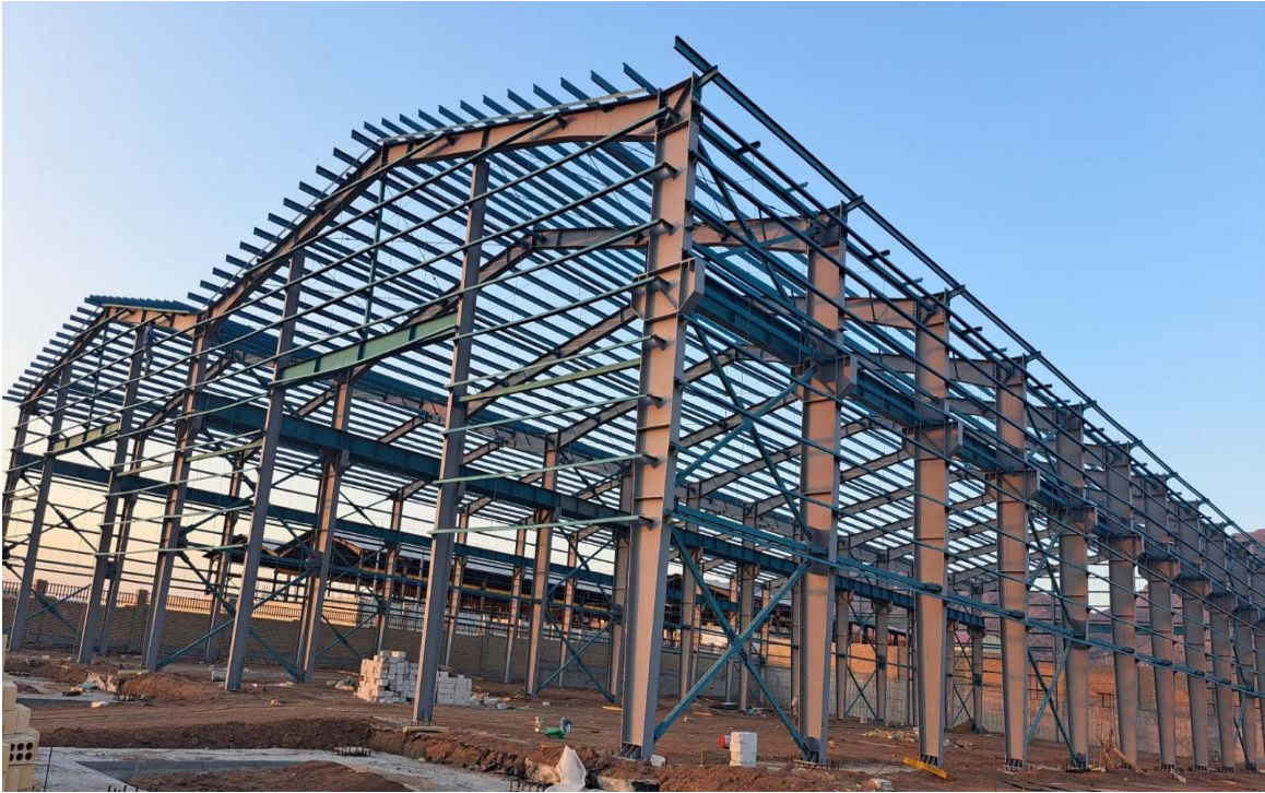
سازه فلزی کارخانه صنایع فلزی در شهرک صنعتی محمودآباد قم - بهمن ۱۴۰۲
