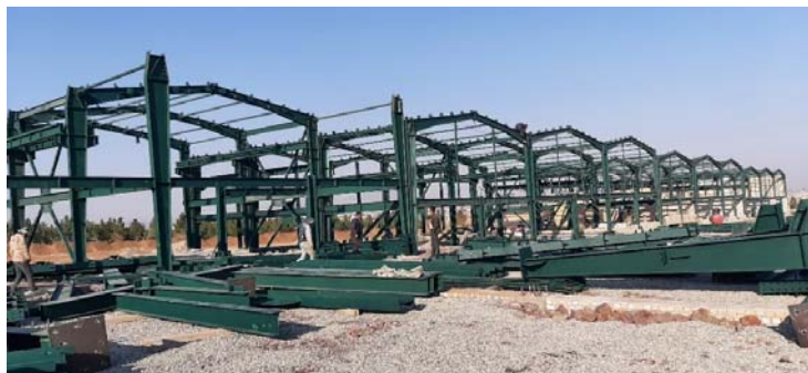
۲۶ دستگاه سوله اجرا شده در شهرک صنعتی دهک فروردین ماه ۱۴۰۲
