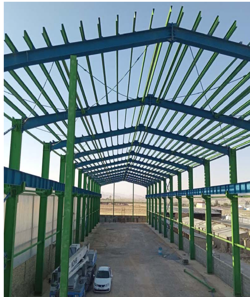
سازه های فلزی کارخانه شهرکرد - تابستان ۱۴۰۳
