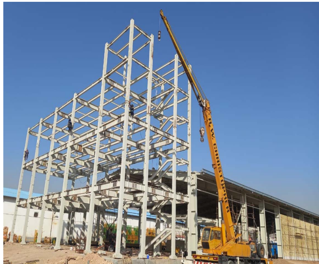
سازه های فلزی کارخانه مینو در شیراز- تیر ۱۴۰۳
