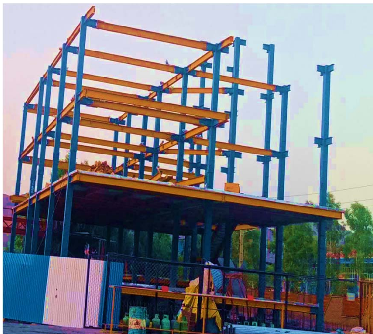
سازه فلزی کارخانه شرکت قیرآکام
